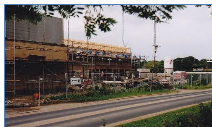
Opbygningen er i fuld gang.
